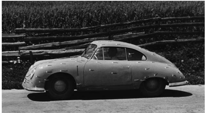
Erste Aerodynamikversuche wurden am Porsche 356 mit aufgeklebten Wollfäden durchgeführt.
